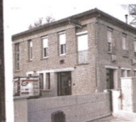
Au rez-de-chaussée d'un bâtiment rénové.
